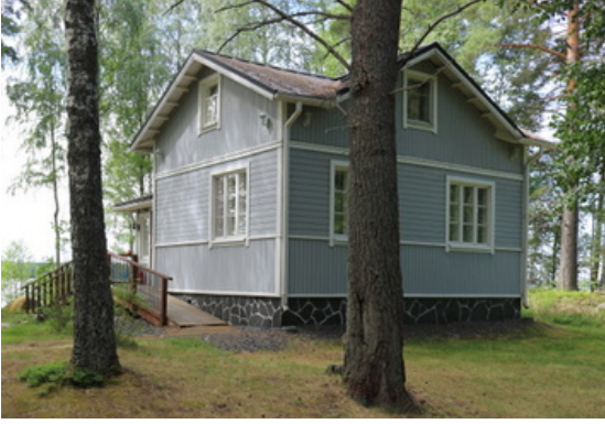
Liuskekivellä pinnoitettu kivelementtiperustus
