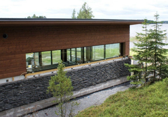
Stonelement-seinäelementit asennetaan tavanomaisesti perustuslinjan päälle
