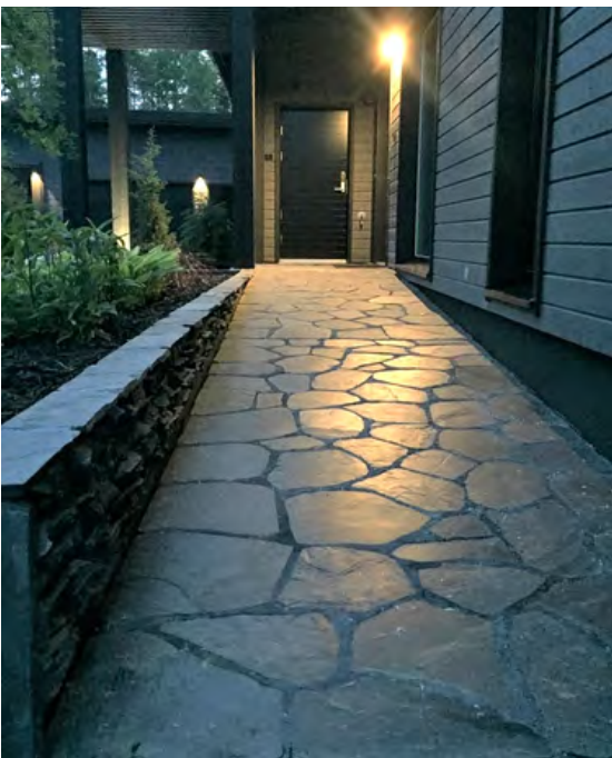
Liuskekivellä pinnoitettu invaluiska
