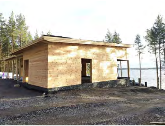
Hirsimökin perustukset sokkelielementeillä
