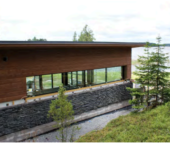
Stonelement-seinäelementit asennetaan tavanomaisesti perustuslinjan päälle
